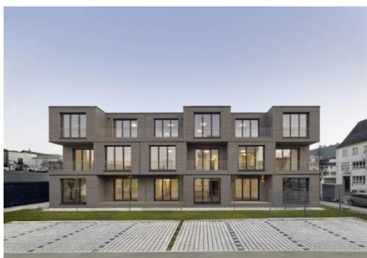
Wohnanlage für Klinikpersonal Esslingen Planungs- und Bauzeit 2018-2019
