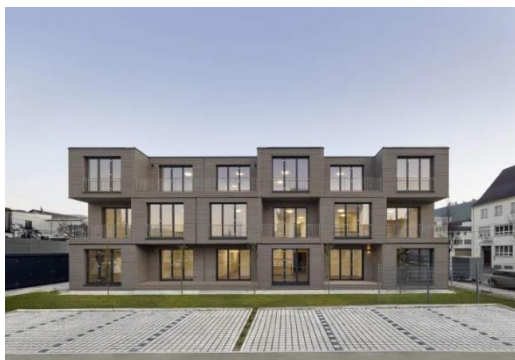
Wohnanlage für Klinikpersonal Esslingen Planungs- und Bauzeit 2018-2019
